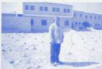
El P. Turu durant la construcció de la pista.
